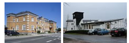
Stationsbygningen og Remisen år 2015
